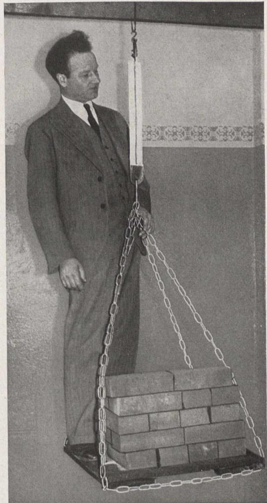
Fig. 3. Lundberg, der Erfinder von Metallfix, auf einem Brett, das außer ihm einen Haufen Ziegelsteine trägt. Die Last von 200 kg hängt an zwei Aluminiumstücken, die durch Metallfix miteinander verklebt sind.
