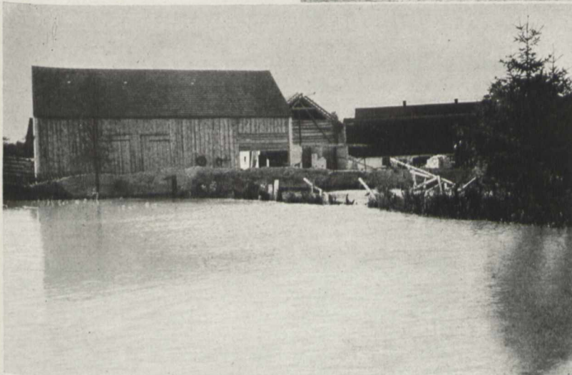
Fig. 3 und 4. An Stelle des Gartens, in dem ein zweiter artesischer Brunnen erbohrt wurde, liegt nun ein großer und tiefer See; dahinter die zum Teil eingestürzten Scheunen
