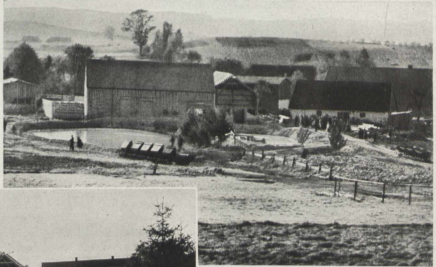
Fig. 3 und 4. An Stelle des Gartens, in dem ein zweiter artesischer Brunnen erbohrt wurde, liegt nun ein großer und tiefer See; dahinter die zum Teil eingestürzten Scheunen
