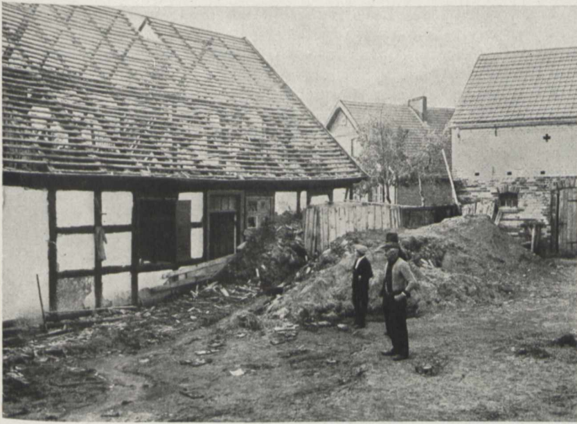
Fig. 2. Das Gehöft in Bussin, in dem ein artesischer Brunnen erbohrt wurde
