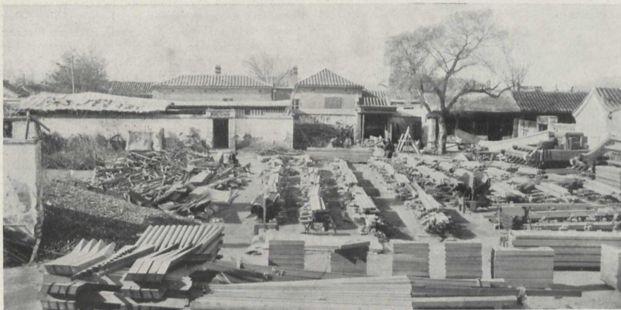
Fig. 4. Der Bauplatz in Peking, wo der goldene Pavillon nachgebildet wird
