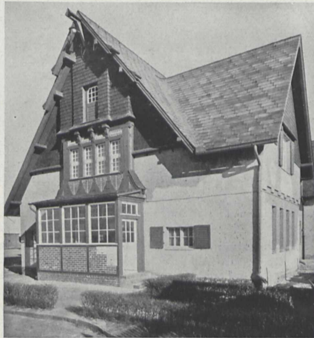
Fig. 3. Dachdeckung mit Asbestzement in der Art der englischen Schieferdeckung
