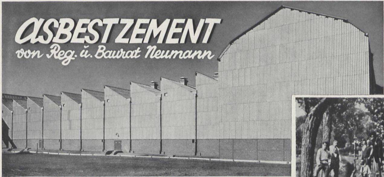
Fig. 1. Hallen mit Wänden aus „Welleternit“, das sind große Asbestzementplatten, die bei der Herstellung wellblechartig geformt wurden
