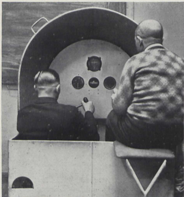
Fig. 1. Attrappe für Ausbildung im Blindflug Vor Beginn des praktischen Blindfliegens wird der Flug nur nach Instrumenten theoretisch an Attrappen geübt (Aufnahme der Deutschen Lufthansa)
