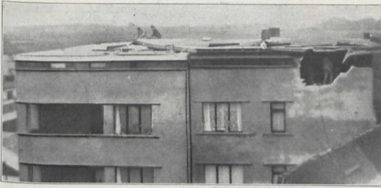
Fig. 4. Das genügend breite Hauptgesims war nicht fest genug verankert: Ein Windstoß hat ganze Mauerstücke herausgerissen und das Dach schwer beschädigt
