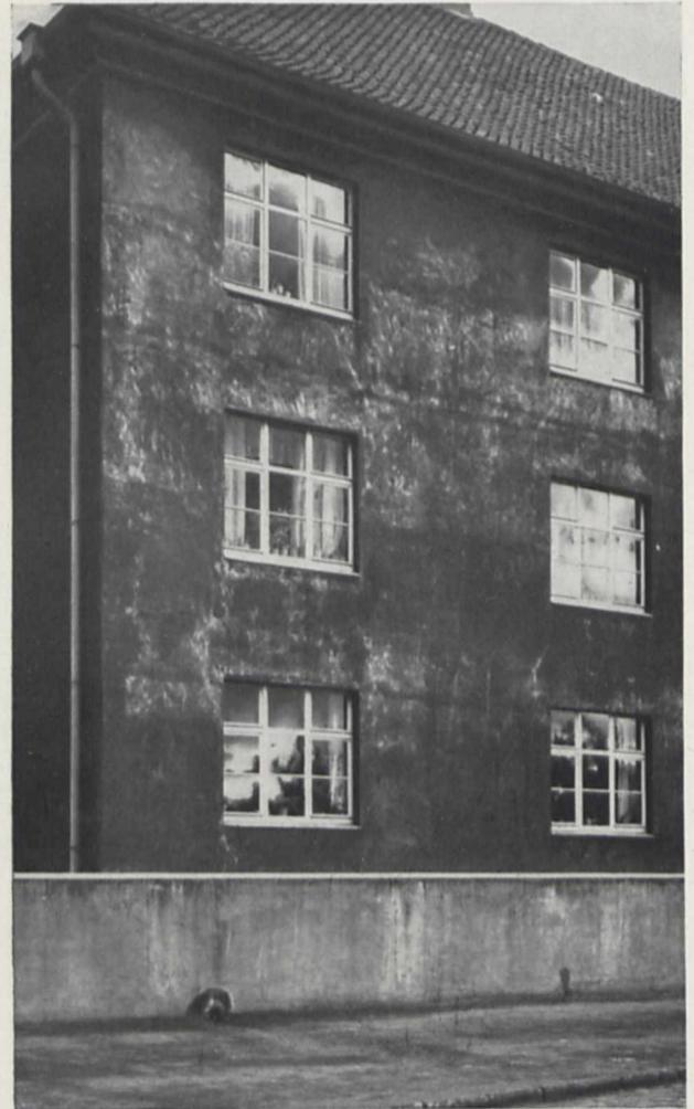
Fig. 9. Das Ergebnis unsachgemäß aufgetragener minderwertiger Bindemittel bei stark farbigen Anstrichen
