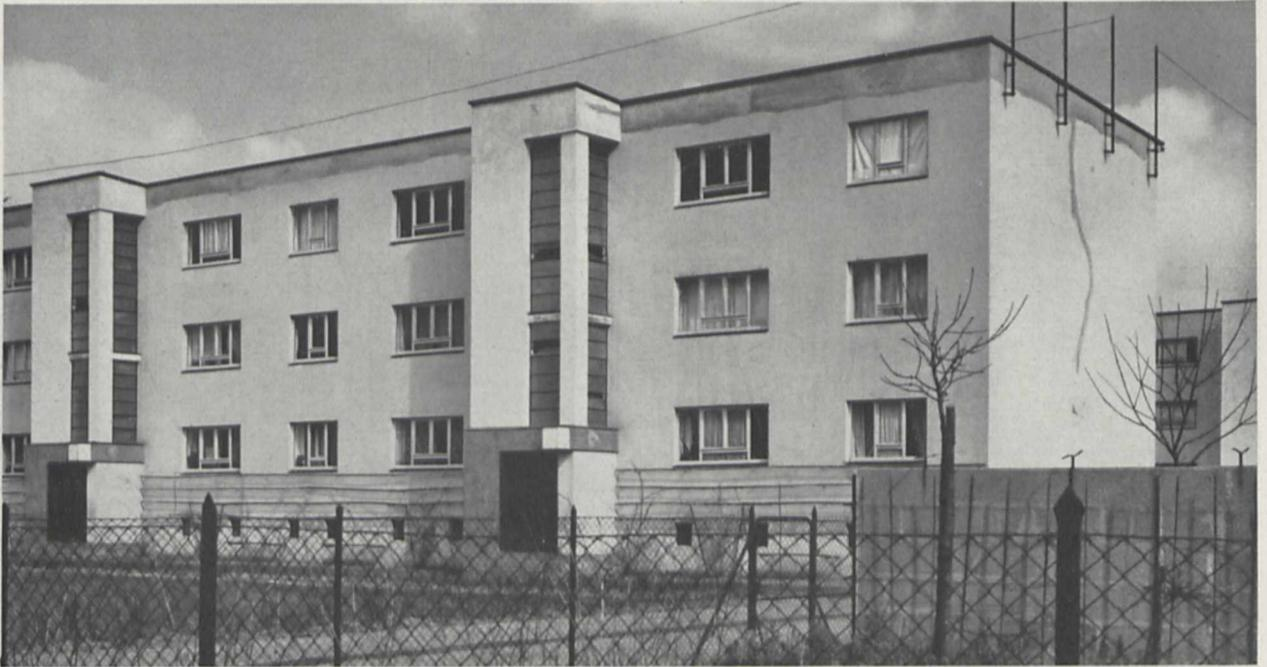
Fig. 2. Das Dachgesims ist zu schmal. Der breite dunkle Streifen direkt darunter ist kein Schlagschatten, sondern durchnäßte Mauer und durchnäßter Verputz.
