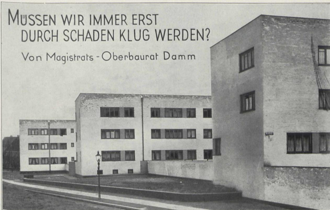
Fig. 1. Wohnhausgruppe aus einer städtebaulich und künstlerisch einwandfreien Reihenhausgroßsiedlung. Durch falsche Dachkonstruktion sind aber überall die oberen Wände durchnäßt, und der Verputz ist abgefallen.
