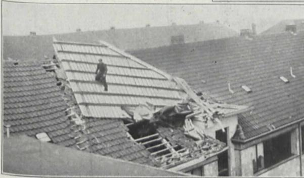
der Errichtung, den finsternen, nassen Dornenkranz auf der Stirn, der erst einen Anfang der Leidenszeit bedeutet; denn durch die unverantwortliche Sorglosigkeit, mit der das Dach konstruiert wurde, sind vorläufig erst die oberen Wohnungswände durchnäßt. Man wird hier noch allerhand erleben können, wenn man nicht bald zur Operation auf Leben und Tod schreitet.
