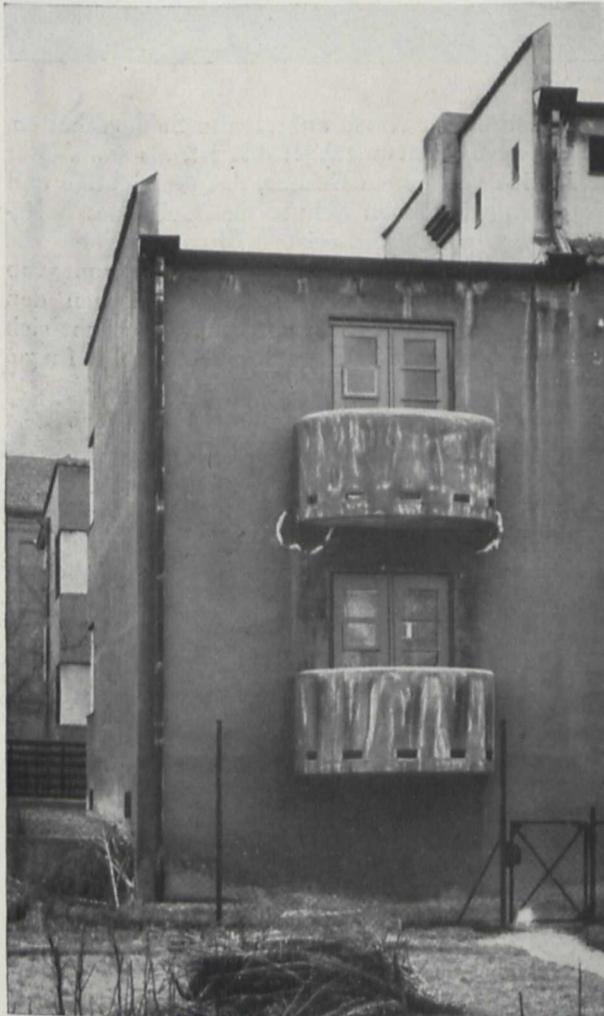
Fig. 8. Freistehendes dünnes Mauerwerk muß vor dem Anstrich mit Abdeckplatten versehen werden, sonst wird der schönste Anstrich zuschanden
