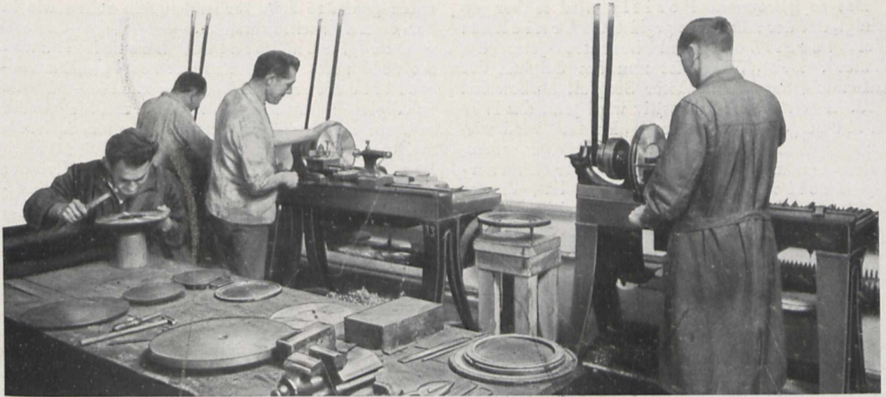
Fig. 5. Aus dem galvanisch hergestellten Negativ werden durch Weiterbearbeitung und Hinterlöten von Messingplatten die Preßmatrizen gewonnen (Küchenmeister-Konzern)
