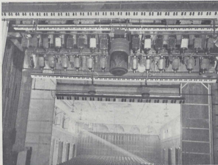
Fig. 1. Ueber dem Bühnenportal, dem Auge des Zuschauers unsichtbar, sind zahlreiche vielfarbige Spezialscheinwerfer angeordnet. In der Mitte erkennt man den großen Wolkenapparat (Fig. 5).
