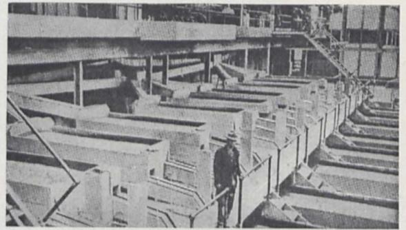
Fig. 3. Schwimmaufbereitungsanlage mit pneumatischen Apparaten: Callow- und MacIntosh-Zellen.
