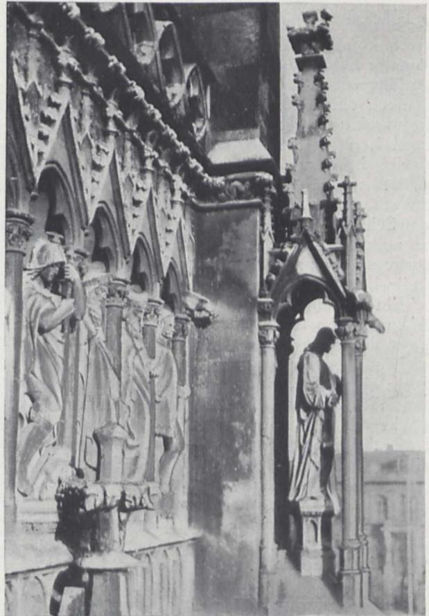
Fig. 5. Figurentürmchen von der Votivkirche, Wien. Durch das Rosten von Eisentraversen wurde der Baldachin zersprengt und der darüber befindliche schwere Fialenaufbau gehoben.
