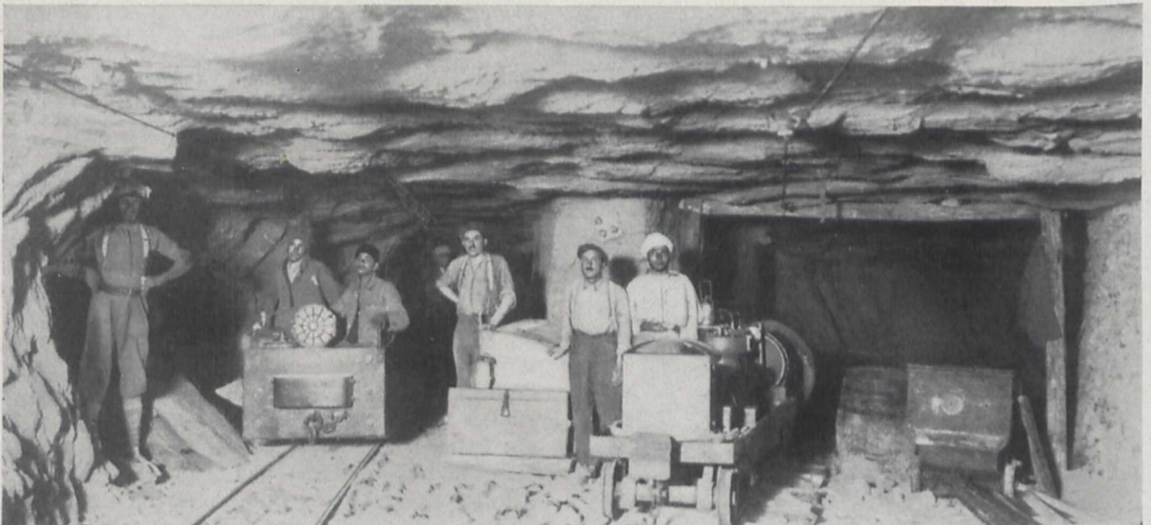
Fig. 6. Von Arabern bediente elektrische Schlepper in der Phosphat-Zeche Kuricha. Foto Montalbano Nichts wird hier mit Grubenpferden oder menschlicher Muskelkraft befördert — die Hunde werden sowohl über wie unter Tage elektrisch betrieben.
