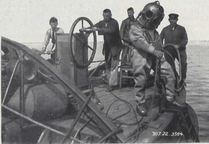
Fig. 4. Mit Dräger-Schlauchgerät ausgerüsteter Taucher im Begriff, in das Meer zu steigen.
