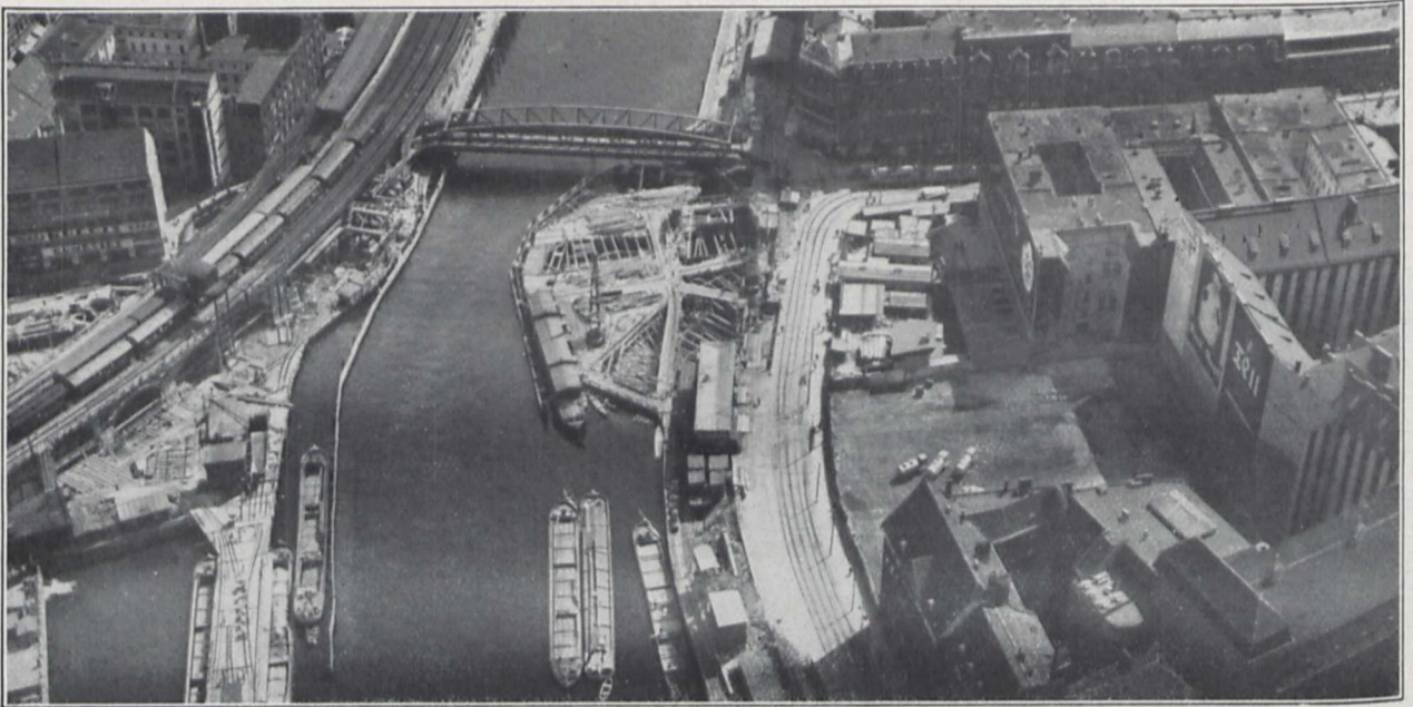
Fig. 3. Der 1. Bauabschnitt des Spreetunnels aus der Vogelschau. (Zum Aufsatz auf S. 374.)
