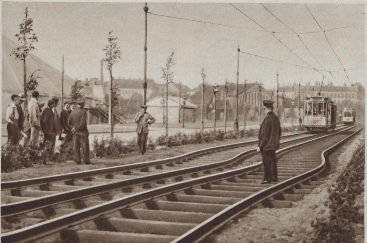
Sonnenhitze verbiegt die Schienen. Aufgenommen von Stud.-Rat O. Junghanns, Leipzig, mit Sprungkamera Ernemann Heag
