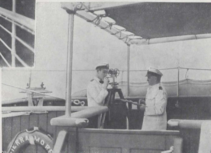
Fig. 2. Messung der Flugbahn des Pilotballons am Theodoliten.
