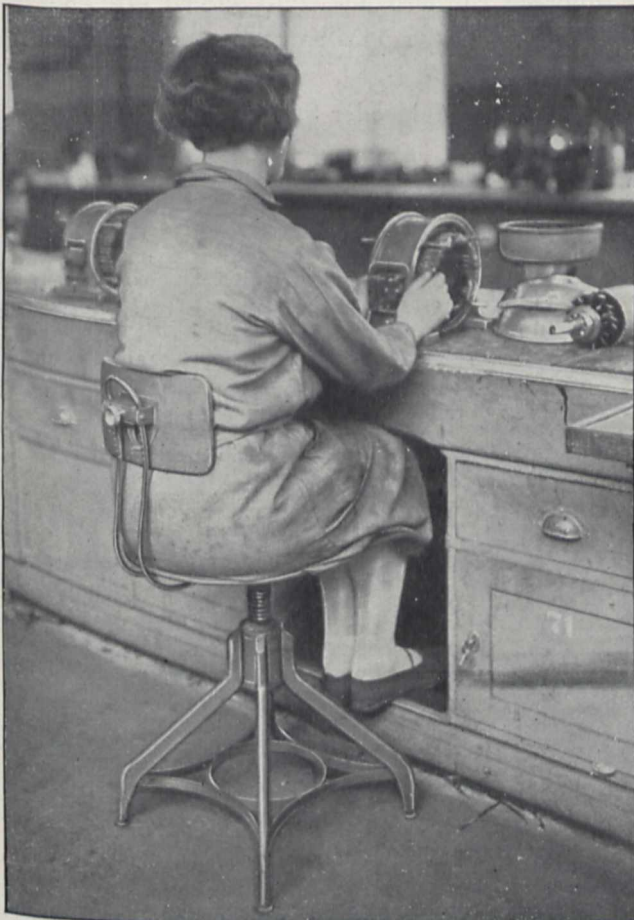
Abb. 7. Zweckmäßiger Arbeitsstuhl am Fließband. Gute Haltung, Knie und Füße haben Platz. (Siemens-Schuckert-Elmo-Werk.) (Aus dem „Reichsarbeitsblatt“.)
