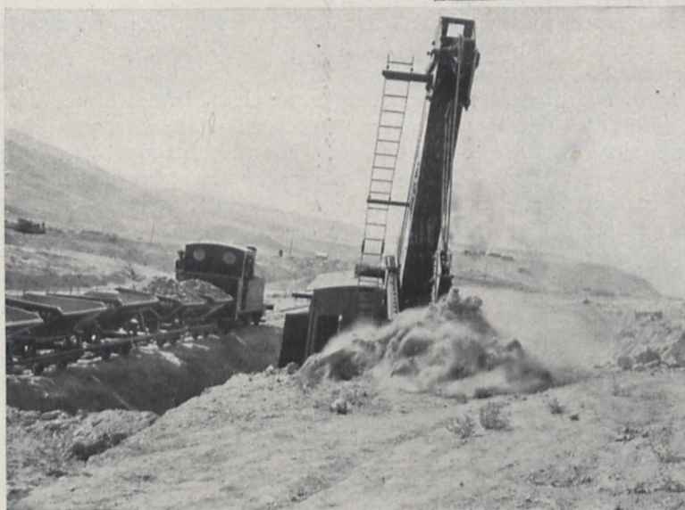
Fig. 3 (unten). Baggerarbeiten für das Kraftwerk I am Jordan (vgl. nebensteh. Karte).
