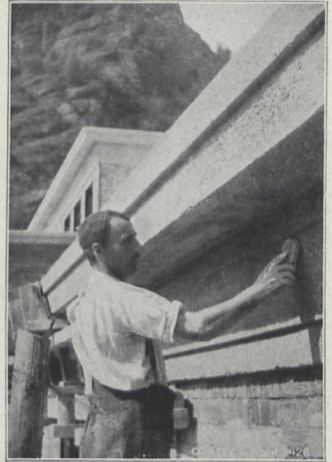
Fig. 8. Nach dem Ausschalen wird die infolge der Contexbehandlung nicht erhärtete Zementhaut abgeburstet, wodurch die Betonstruktur zum Vorschein kommt.
