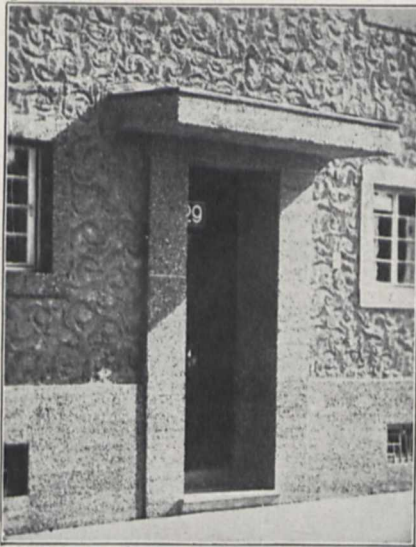
Fig. 4. Mit ConTEX behandelter Beton-Türrahmen eines Reihenwohnhauses in München.
