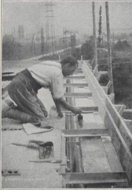
Fig. 7. Die Schalung eines Gesimses wird mit Contex gestrichen.
