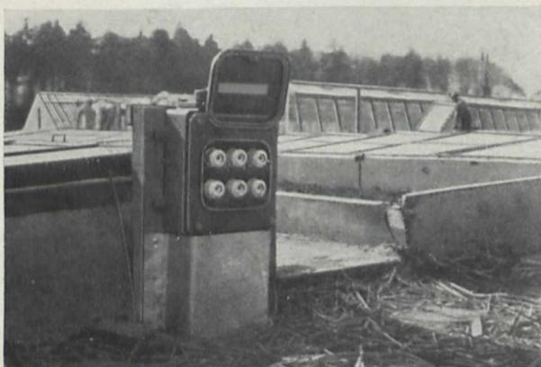
Fig. 2. Elektrischer Verteilerkasten für die Bodenheizung.
