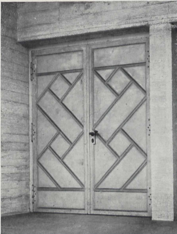
Fig. 6. Tür aus Siluminguß an einem Frankfurter Messehaus.
