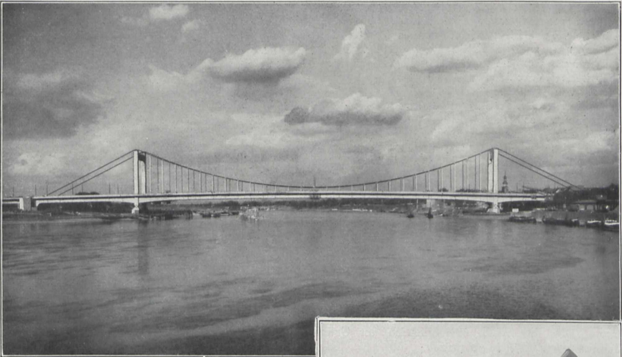
Fig. 1. Die neue Hängebrücke Köln—Mülheim.
