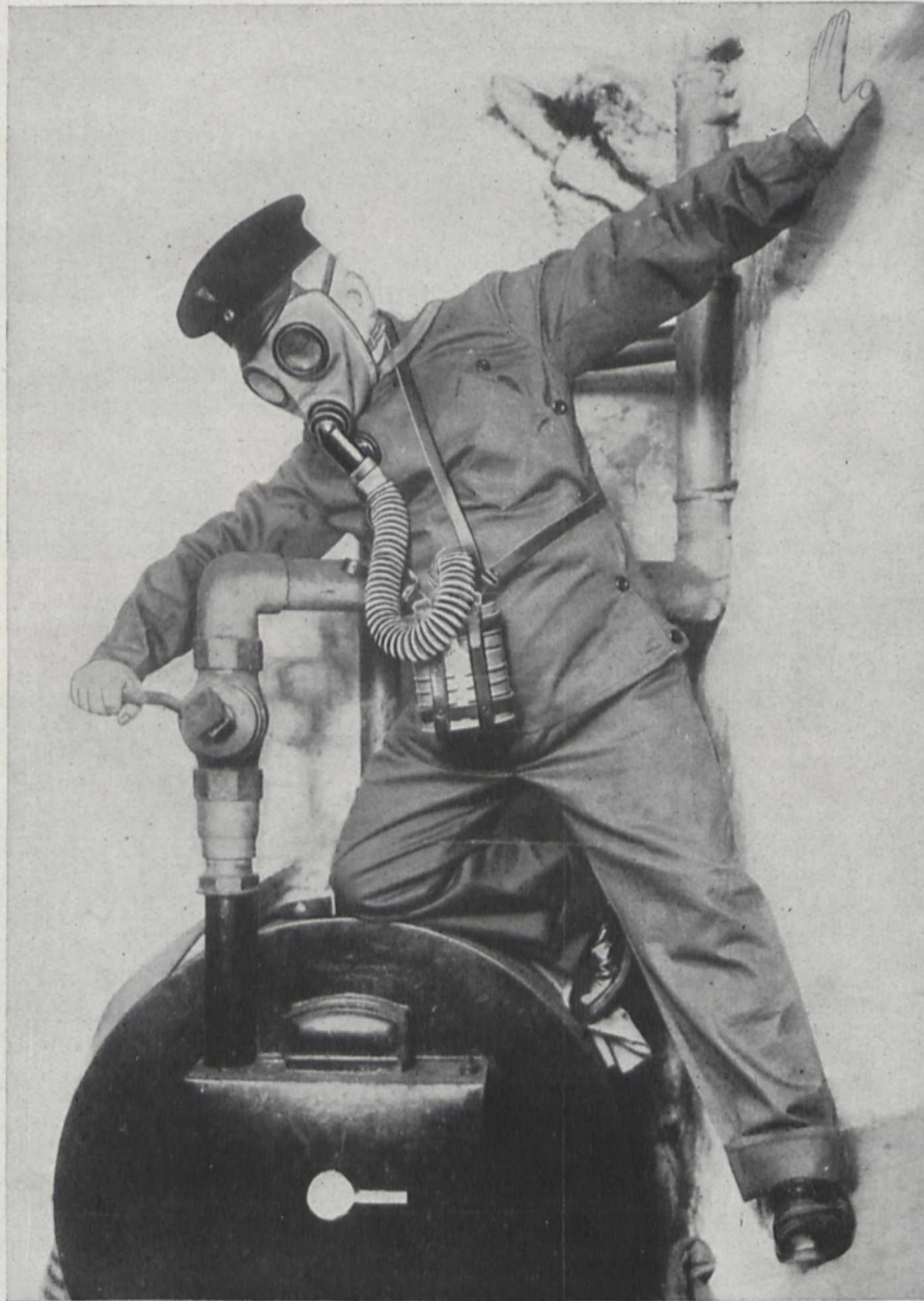
Abspernung eines Gasometers infolge einer undichten Gasleitung.
