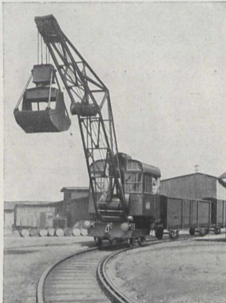
Fig. 3. Dieselmotor-Rangierdrehkran
