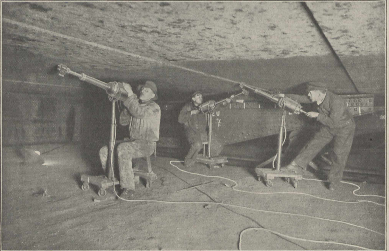
Entrostung eines Schiffsbodens.
