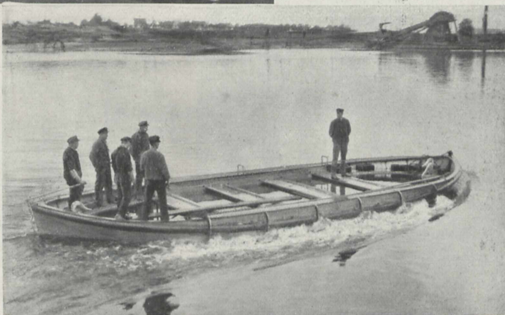
Fig. 2. Voll Wasser geschlagenes Rettungsboot während der Probefahrt.
