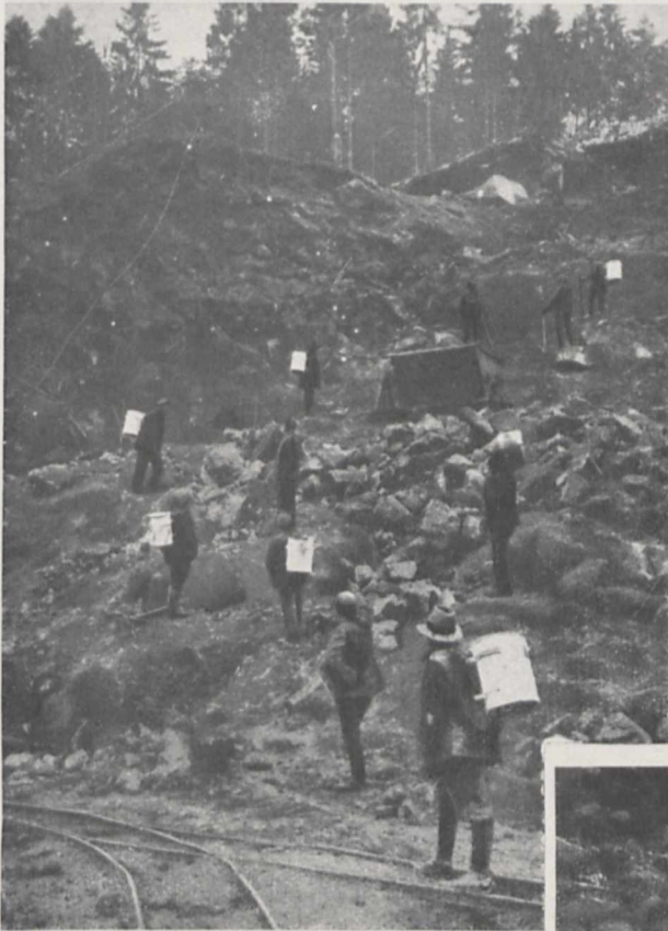
Fig. 2. Transport der flüssigen Luft in Traggefäßen zur Sprengstelle.
