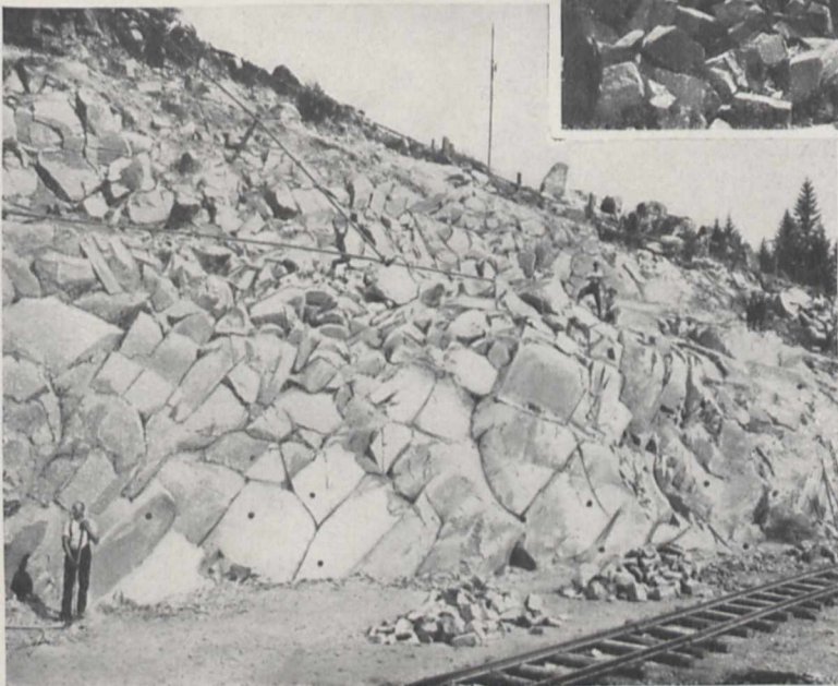
Fig. 3. Unten: Steinbruch vor der Sprengung. (Man beachte die für die Aufnahme der Sprengluftpatronen gebohrten Sprenglöcher.)
