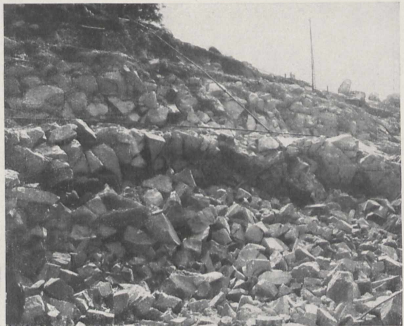
Fig. 3. Unten: Steinbruch vor der Sprengung. (Man beachte die für die Aufnahme der Sprengluftpatronen gebohrten Sprenglöcher.)
