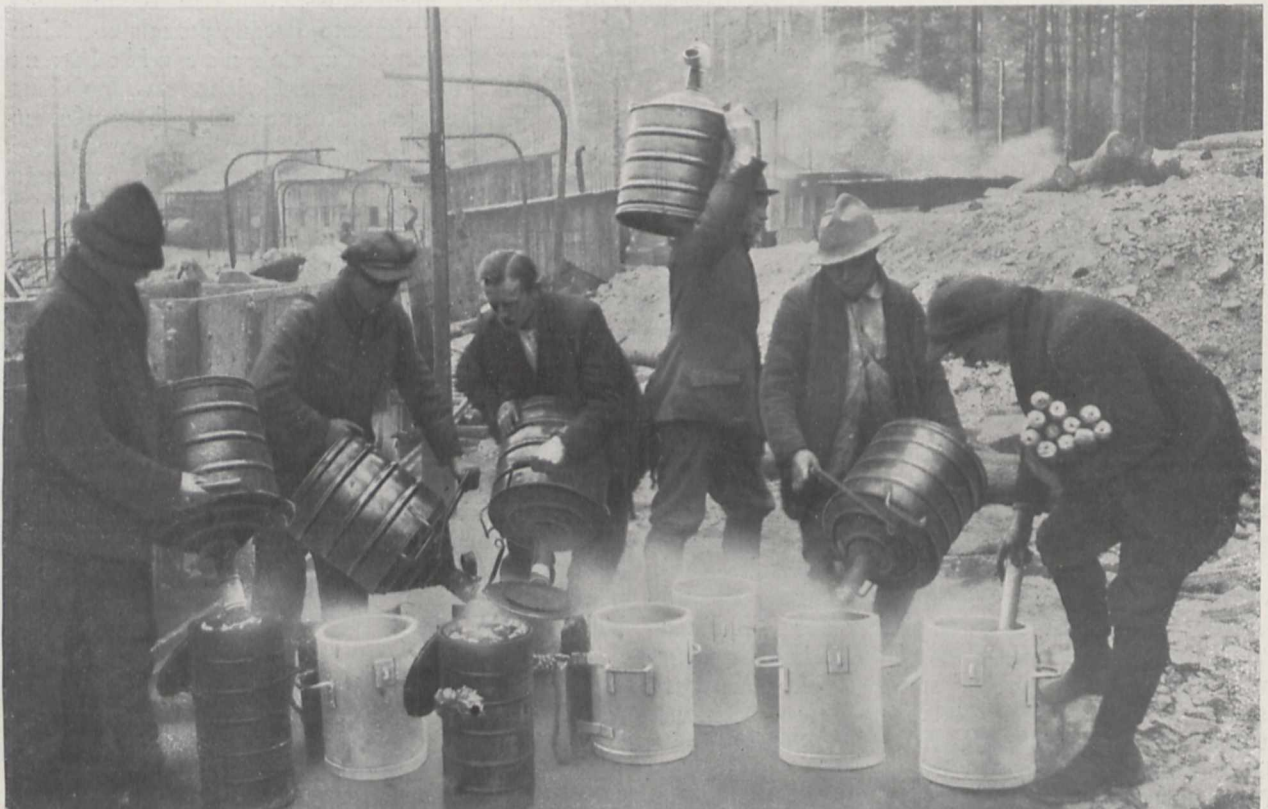
Fig. 1. Tränken der Sprengluftpatronen mit flüssiger Luft.
