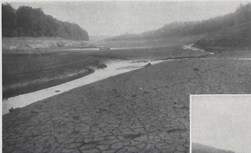
Fig. 2. Der Beverbach auf der Talsohle der ausgetrockneten Bevertalsperre.
