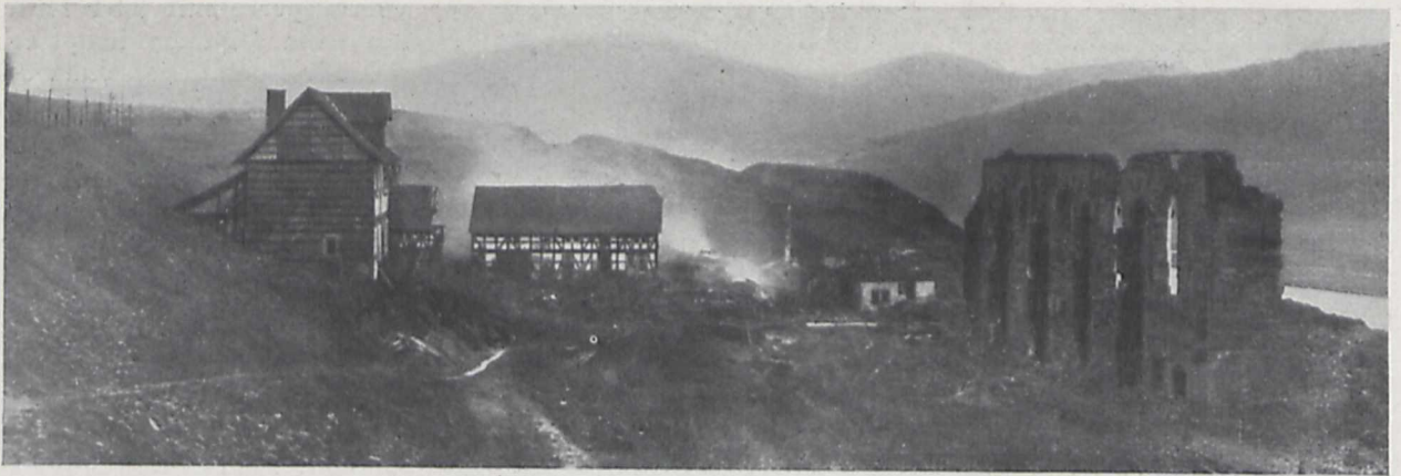
Fig. 8. Die Ruinen des Dorfes Berich an der Eder im Jahre 1913, kurz vor Inbetriebnahme der Edertalsperre. Er wurde niedergelegt und ist bei normalem Wasserstand von etwa 40 m vollkommen überflutet.
