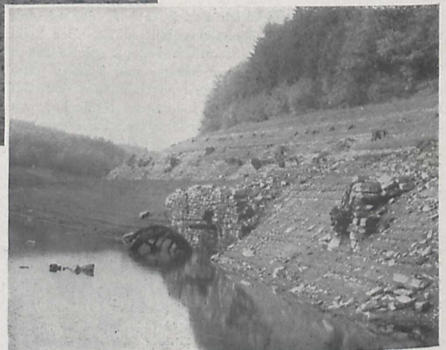
Fig. 3. Reste eines alten versunkenen Hammerwerks im westlichen Arm der ausgetrockneten Talsperre.
