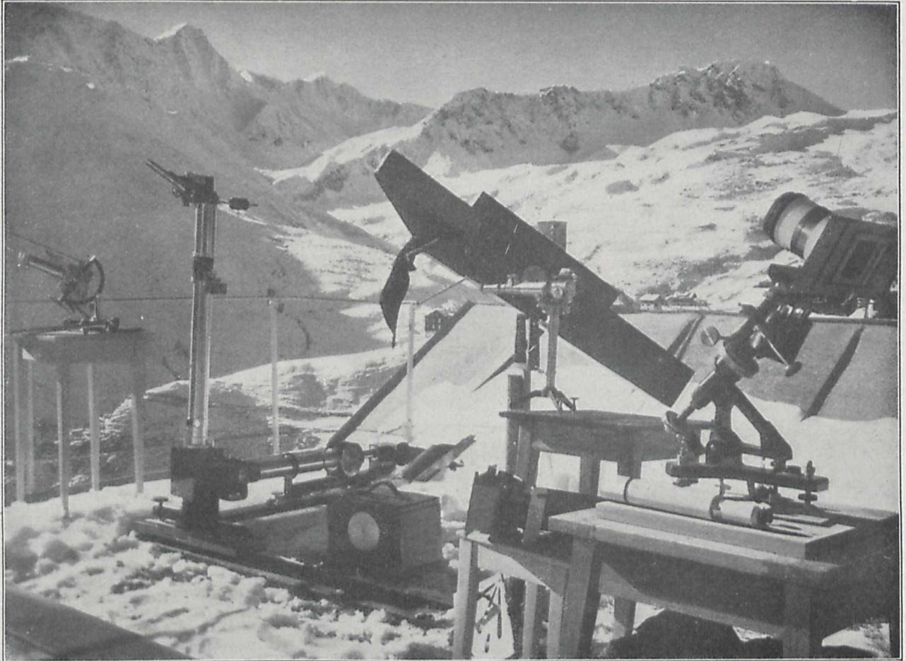
Apparate zur Messung der Sonnenstrahlung in Arosa.
