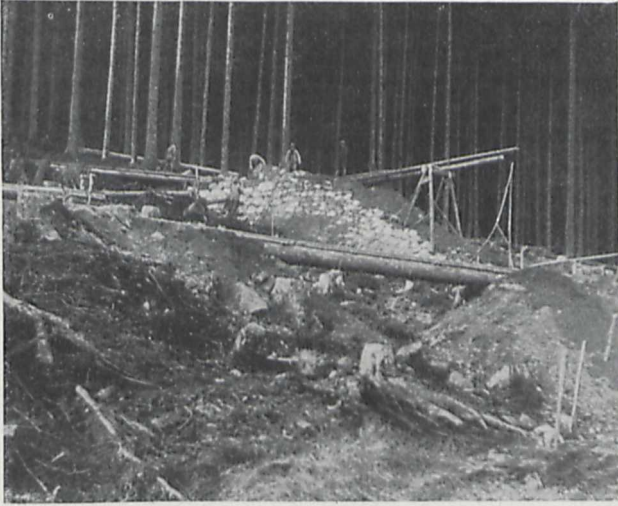
Bau einer Kurve der Bob- und Rodelbahn in Oberschreiberhau
