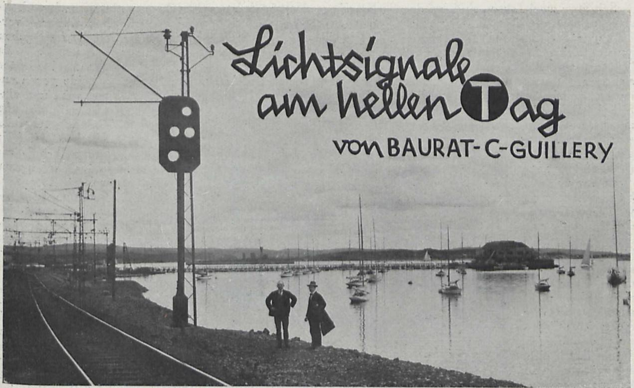
Fig. 1. Strecke der norwegischen Staatsbahn mit Tageslichtsignal.
