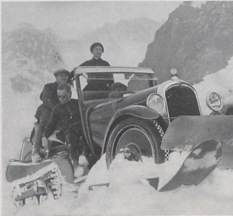
Fig. 1. Das Citroën-Raupen-Auto auf dem Julier-Paß; am Steuer der Erfinder des Wagens A. Kégresse.
