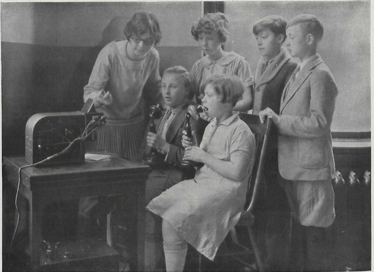
Fig. 2. Taubstumme lernen sprechen mit Hilfe des Osiso. Sie sehen im Apparat die Schwingungskurve des gesprochenen Lautes und erkennen daraus, ob die Lautbildung richtig oder falsch war.
