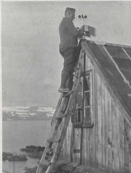
Fig. 2. Aufbau des Universal-Anemographen.
