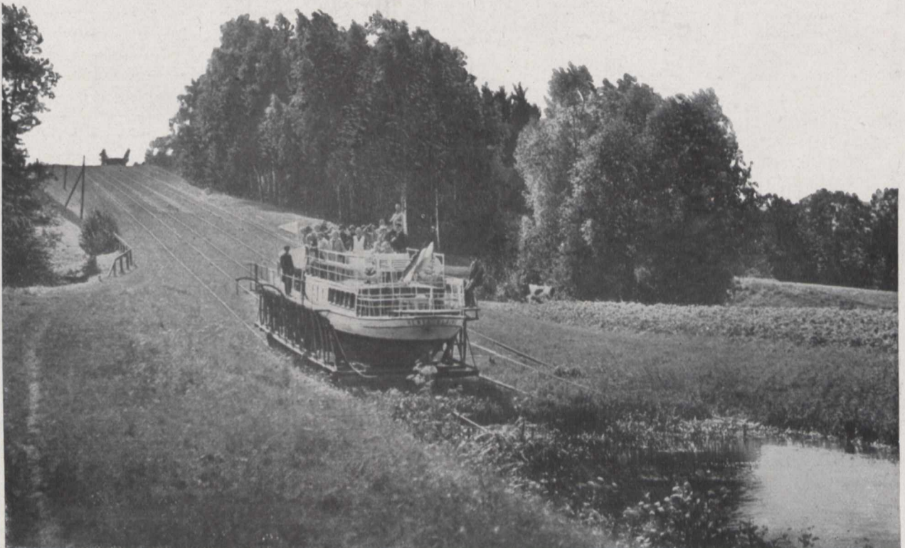
Fig. 2. Der Eisenbahnwagen mit dem Schiff rollt bergaufwärts.
