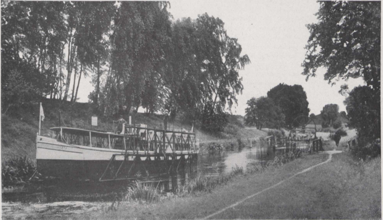
Fig. 1. Das Schiff ist auf den Eisenbahnwagen geglitten, der es, auf Schienen rollend, über die geneigte Ebene zum nächsten See befördert.
