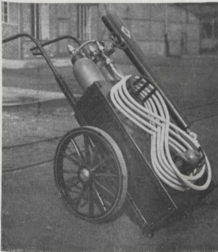
Fig. 2 (unten). Fahrbarer Total-Löschapparat für größere Fabrikanlagen, der den Kohlendensäureschnee auf brennende Flächen schleudert.
