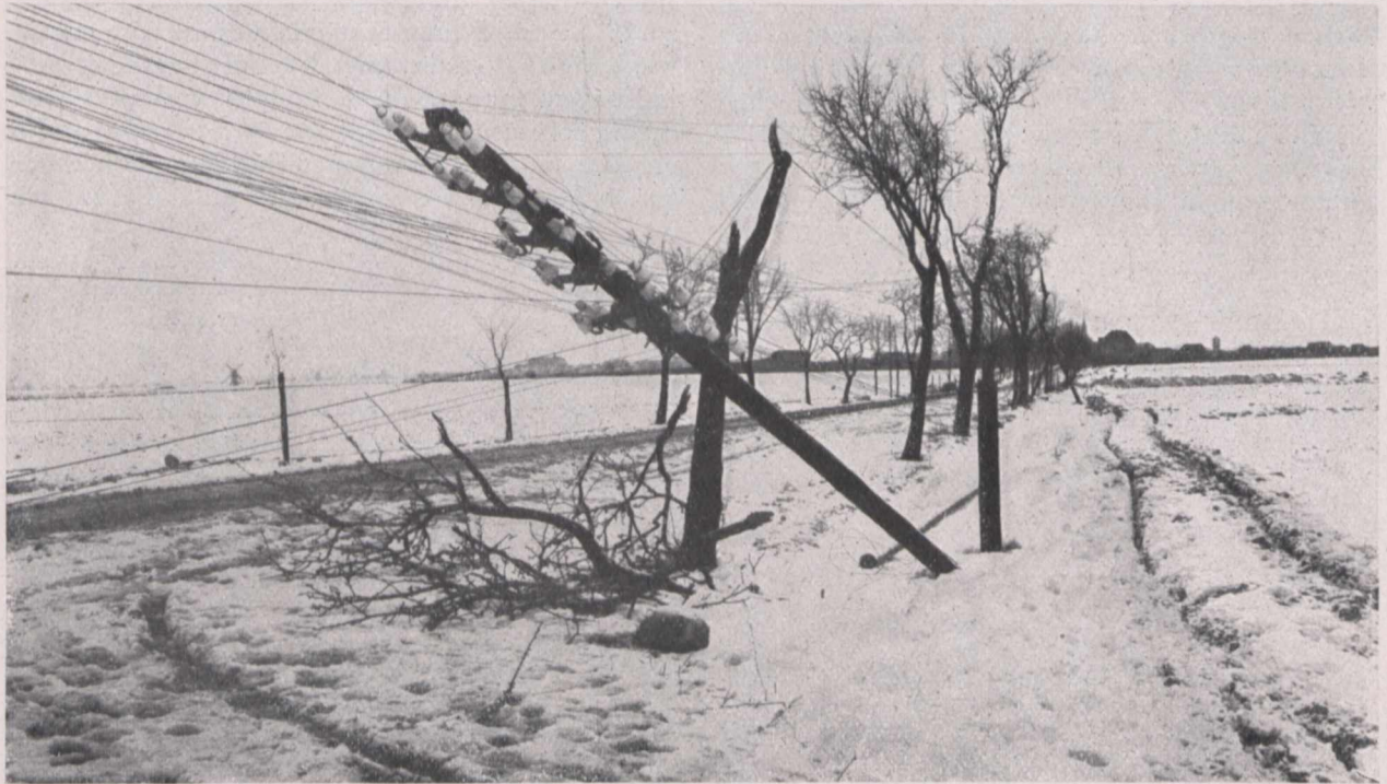
Fig. 2. Durch Schneesturm zerstörte Fernsprechleitungen.
