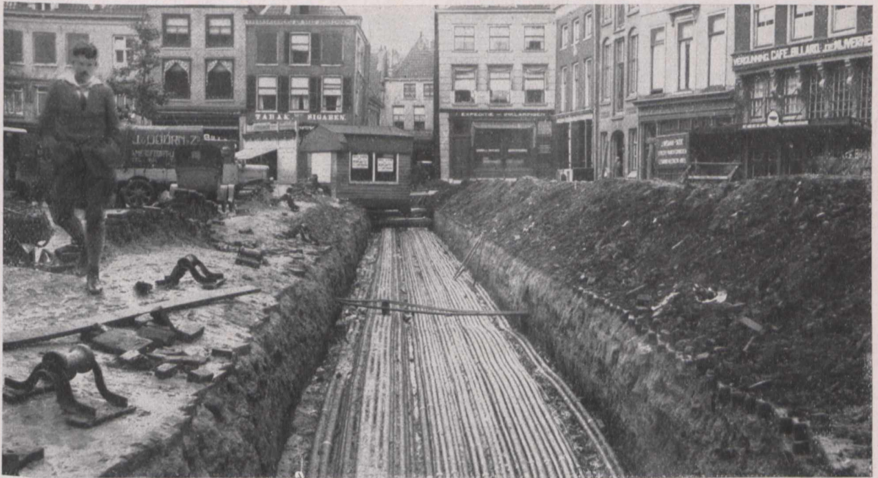
Fig. 4. Kabelverlegung in einem Stadt-Fernsprechnetz.
