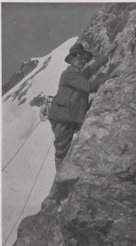
Fig. 6. Vom Jungfraujoch bis zum Gipfel wird eine Telephonleitung gelegt.
