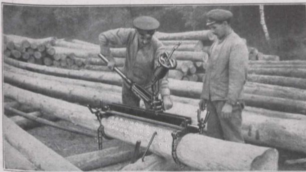
Fig. 1. Imprägnierung an liegenden Masten.
