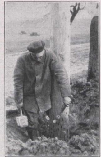
Fig. 5. Cobraimprägnierung am stehenden Mast.
