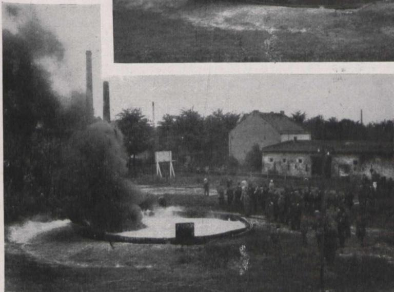
Fig. 3. Der gleiche brennende Oeltank wie in Fig. 2. Durch den Schaum ist der Brand bereits fast ganz gelöscht.
