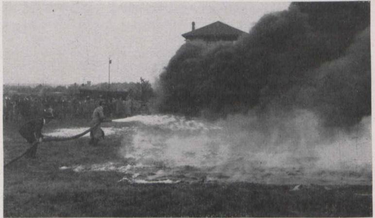
Fig. 1. Auf ein brennendes Teerfeld wird zum Löschen Schaum mittels Spritzröhren aufgebracht.
