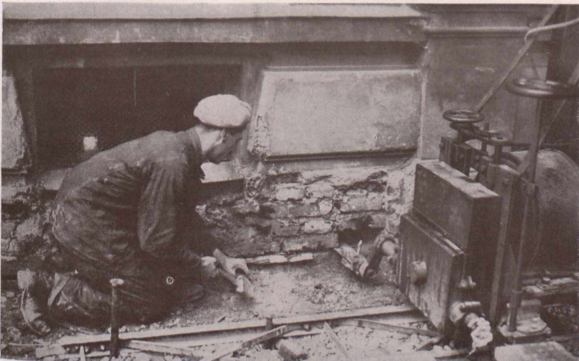
Fig. 6. Durchsägen der Grundmauern und Eintreiben der Bleiplatten zur Trockenlegung des Jagdschloßchens in Nymphenburg bei München.
