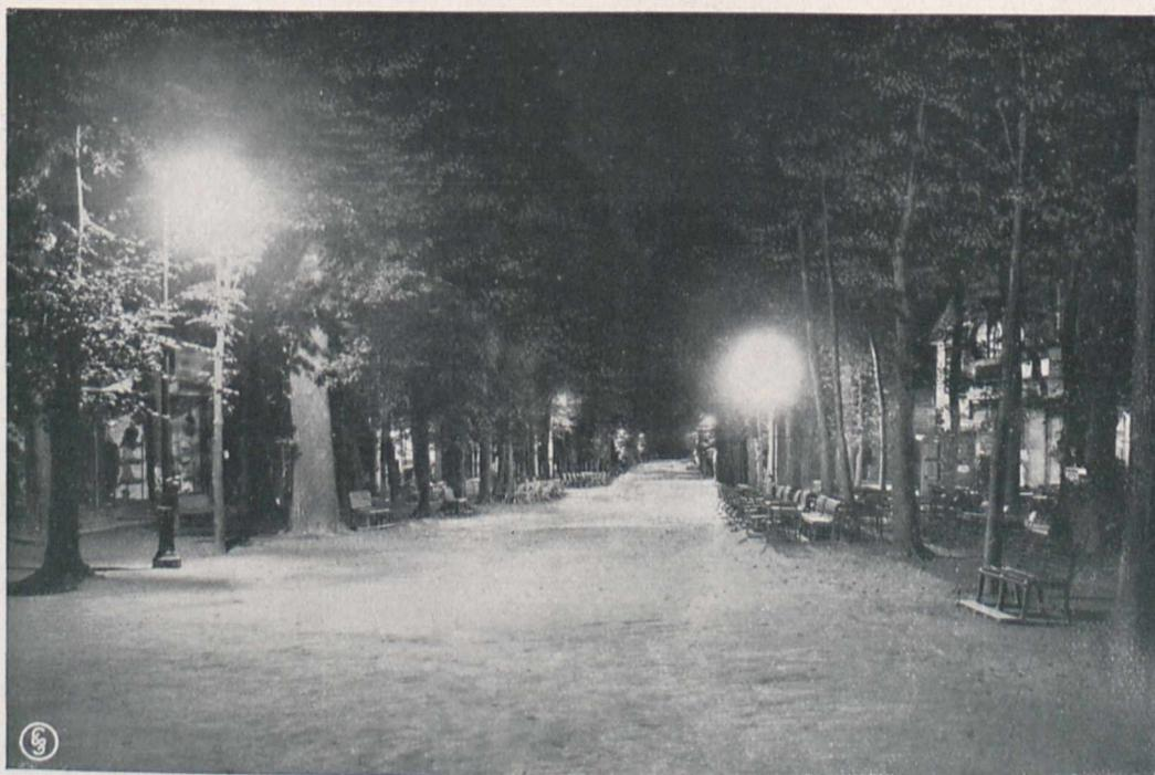
*Fig. 2. Gleichmäßige Beleuchtung einer Allee mit Glühlampen.*
