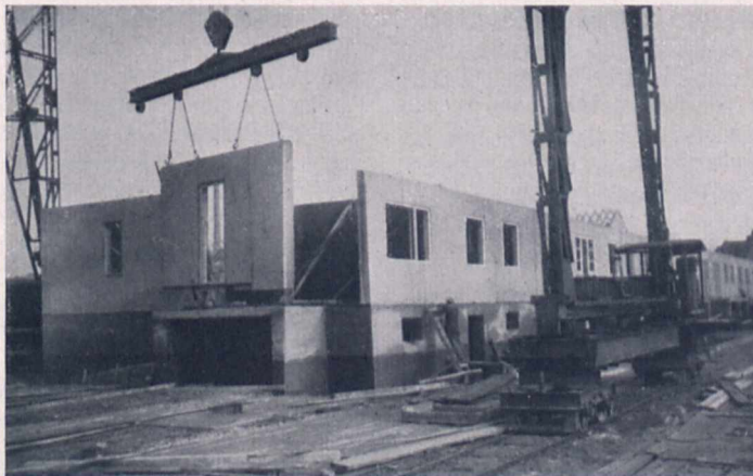
Fig. 3. Die fertigen Wandplatten werden zusammengesetzt.
