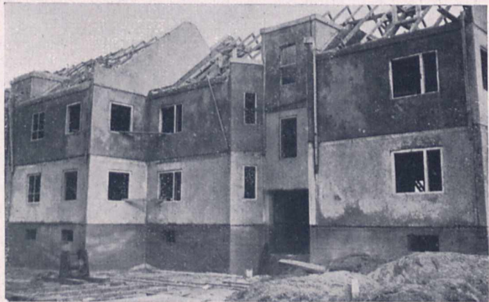
Fig. 4. Die im Rohbau fertiggestellten Wohnungen.
