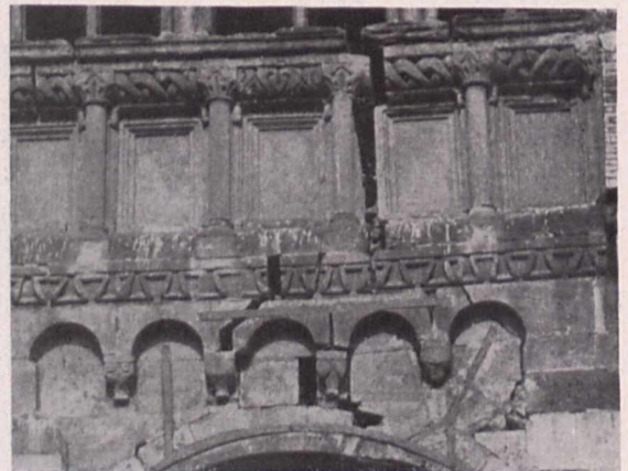
Fig. 4 (rechts). An der Galerie über dem mittleren Fenster des Westchores klaffen weite Sprünge, z. T. 20 cm breit.
