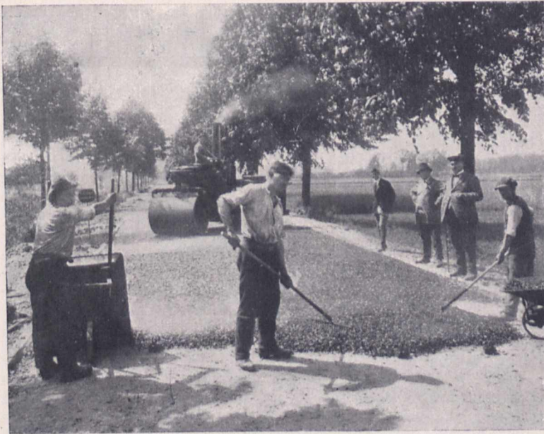
Fig. 12. Die Straße wird eingedeckt und nachher festgewalzt.
