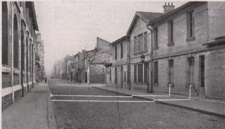
Fig. 3. Versuchsstraße und Versuchsstation, an denen die Studien über die Erschütterungen durch Lastkraftwagen vorgenommen werden. Die weißen Striche bezeichnen die Kontaktstreifen, welche zu den Apparaten in dem Gebäude (rechts) führten.
