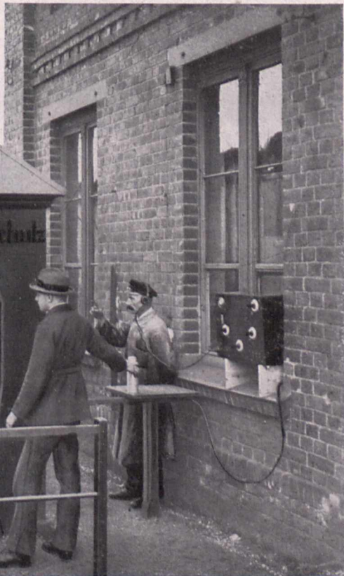
Fig. 2. Werkschutz-Anlage am Eingang einer Fabrik. Alle Personen, die das Werk verlassen, müssen das Tor passieren. Führen sie Metallteile mit sich, so macht sich das durch einen Ton im Kopfhörer des Kontrollbeamten bemerkbar.
