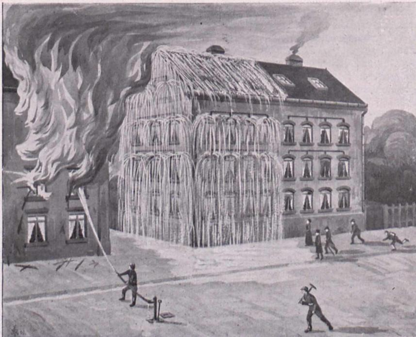
Fig. 1. Deutsche Brauseanlage, die beim Brand des Nachbarhauses in Tätigkeit gesetzt wird und das Uebergreifen der Flammen verhindert.
