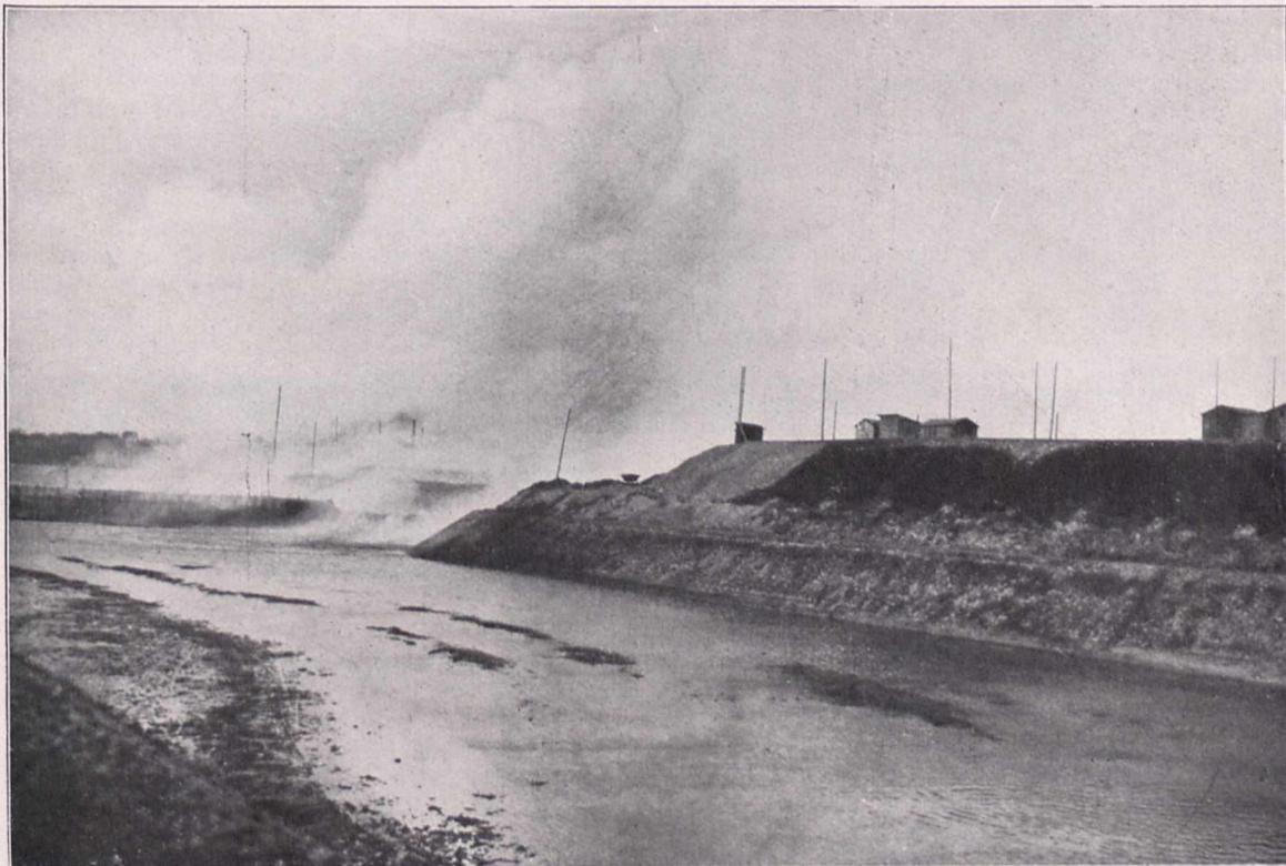
*Fig. 3. Sprengung des Dammes, der Kocher und Neckarkanal trennte.
