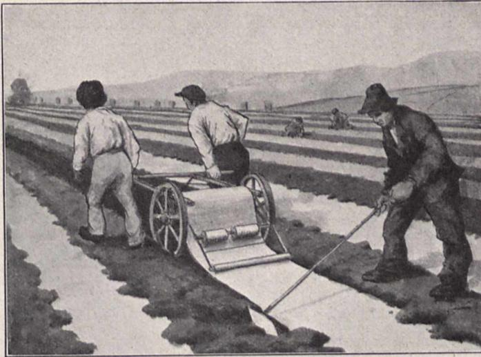
Fig. 2. Maschine, welche die Asphaltpappe verlegt.
