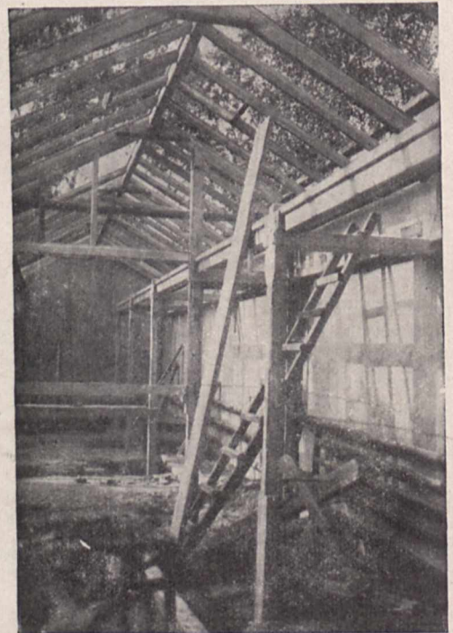
Glasdachsprossen aus Eisenbeton für ein Gewächshaus.
