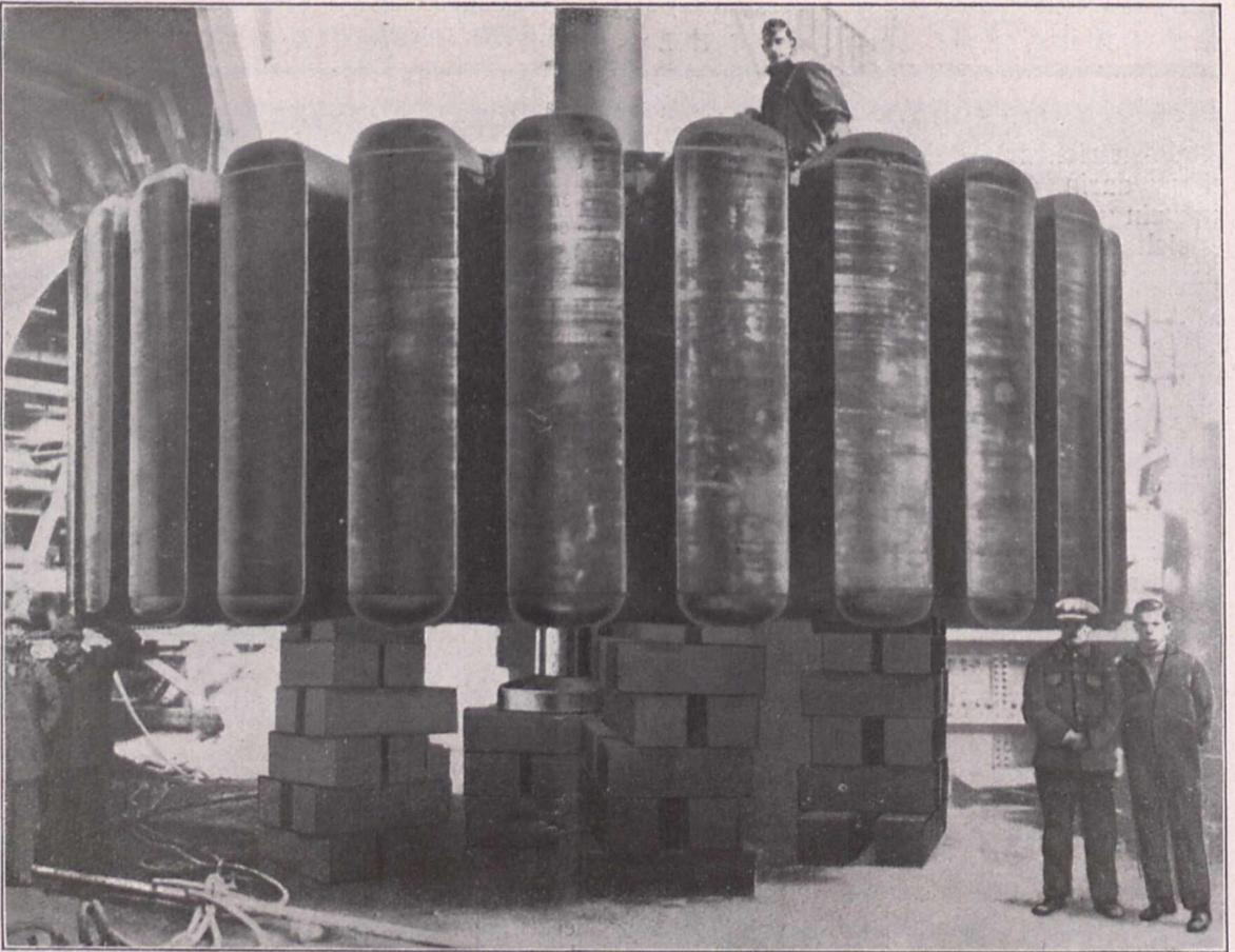
*Fig. 1. Der Rotor des Generators für das Niagara-Kraftwerk.*
