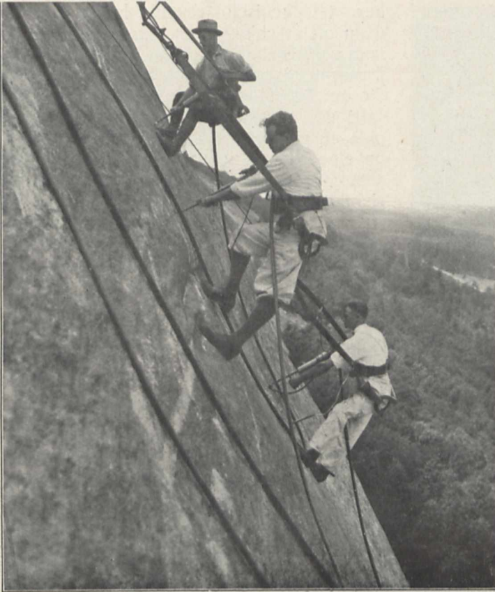
Publisher's Photo Service. Fig. 3. Ingenieure bohren Löcher in die Felswand entlang den Konturen der Zeichnung.
